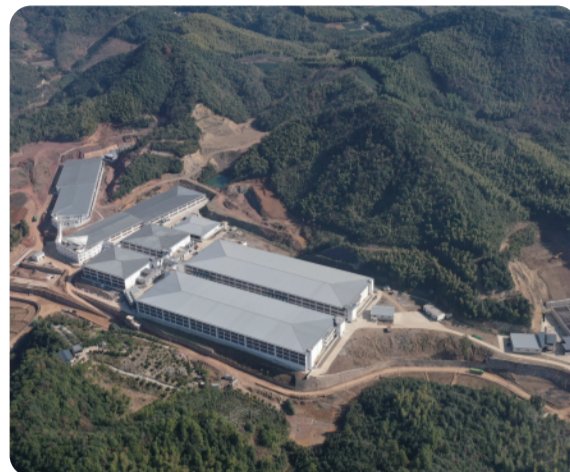
富阳桐坞场坐落于富阳区新登镇官山村，设计规模为4500母猪+50000育肥年出栏10万头，致力于建设一体化现代楼房养殖场。
